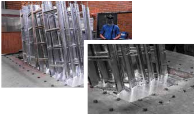
Instalação da própria galvanização a fogo.
