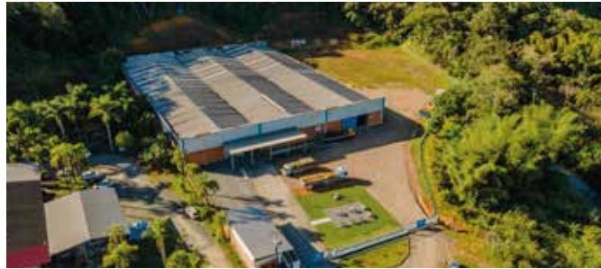
Instalação da Eletropoll Painéis Elétricos, a segunda unidade do Grupo.
