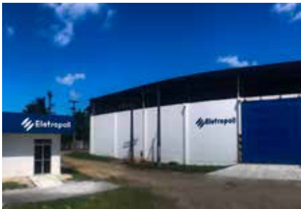
Instalação da Unidade de Bandejamento em Cabo de Santo Agostinho (Pernambuco).
