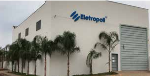
Unidade de Painéis Elétricos instala o próprio Centro de Distribuição em Ribeirão Preto (SP).
